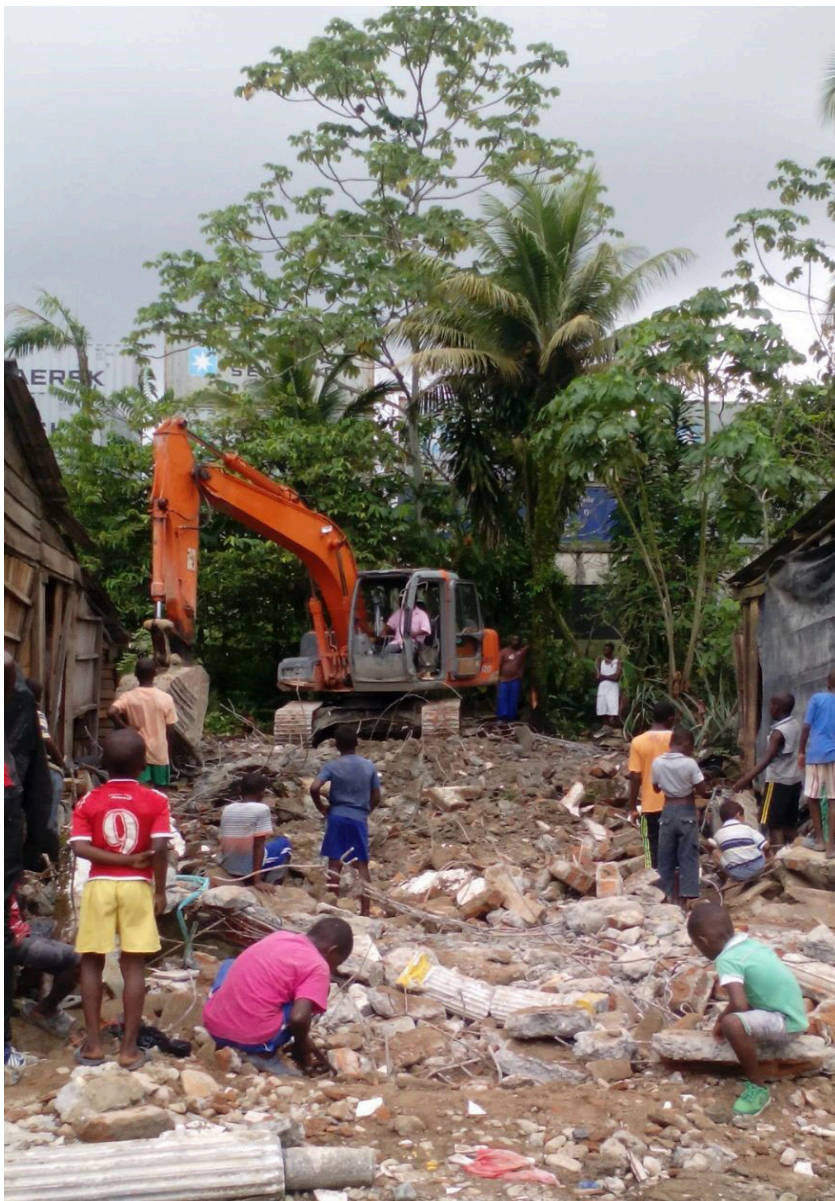
Demolición de la vivienda por parte de TC.BUEN sin autorización de Don Alfonso, en Septiembre de 2015
