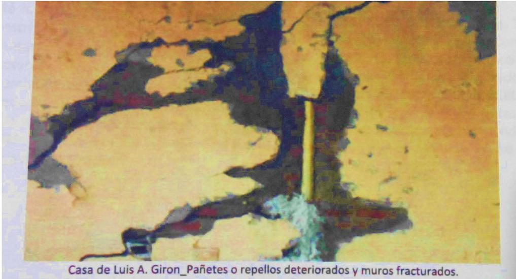
Casa de Luis A. Giron\_Pañetes o repellos deteriorados y muros fracturados.
